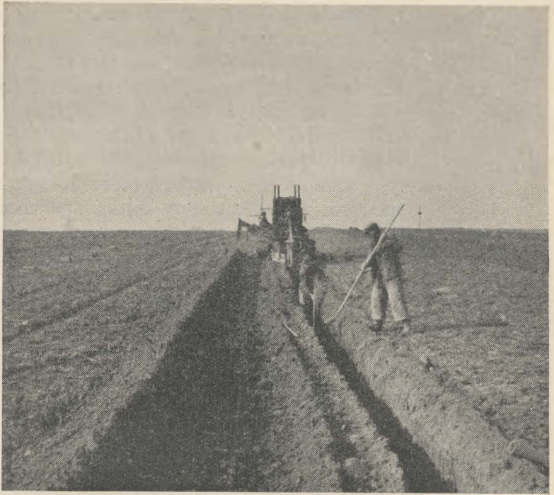
Pose des tuyaux de poterie
