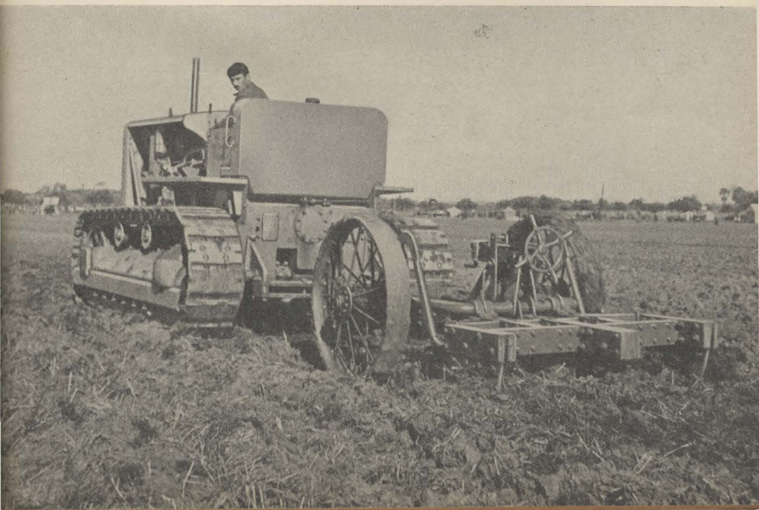
Sous-soleuse tractée par un tracteur à chenilles.
